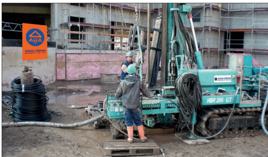
Bauarbeiten im Bereich der Erdsonden
