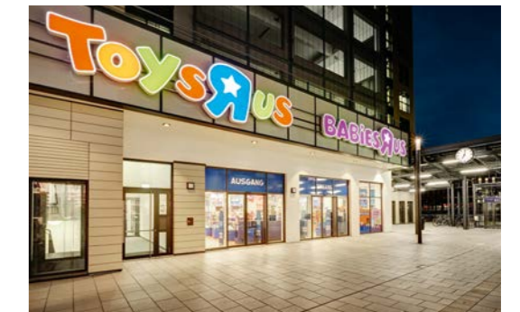
Beispiel Toys'R'Us (in Bauabschnitt 1 realisiert)
